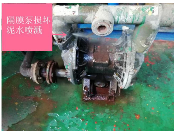
1 镍系污泥压滤机进料隔膜泵损坏， 致使部份污水喷溅到地面
